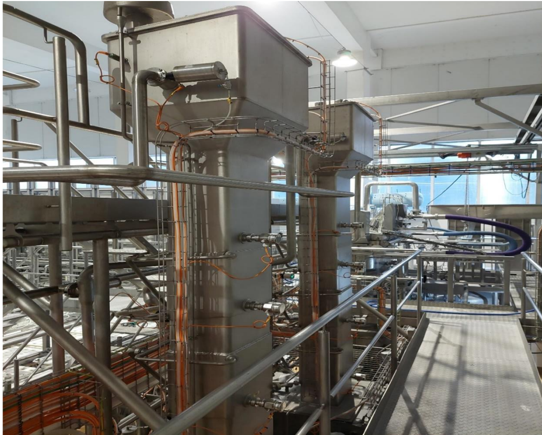
Fot. 5. Część środkowa systemu kolumnowego z sekcjami perforowanymi do odczerpywania serwatki, widok czujników
