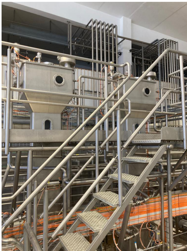
Fot. 4. Widok górnej części systemu formująco-prasującego – komory buforowe/dozujące
